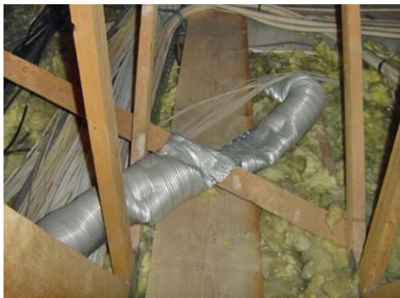
Figure 19 : Écrasement de gaine (source : contrôles Promotelec).
